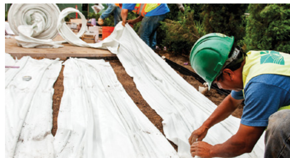
Пример установки Eco-Mat
